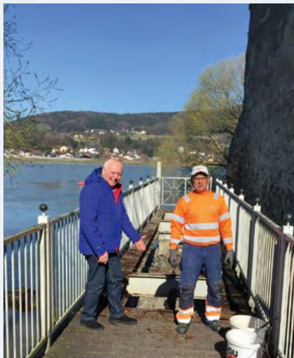
Vizebgm. Herbert Scheuchelbauer inspiziert den Bau-fortschritt bei den Klosterkugeln.
