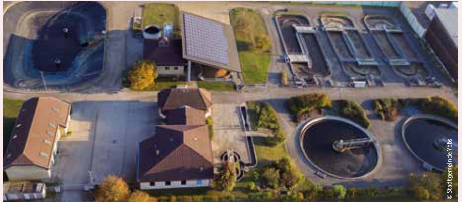
Die Kläranlage aus der Vogelperspektive
