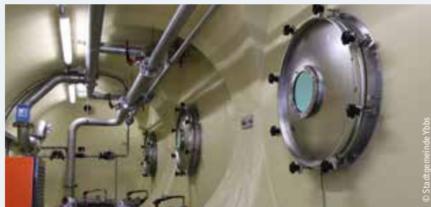
Innenraum des Hochbehälters
