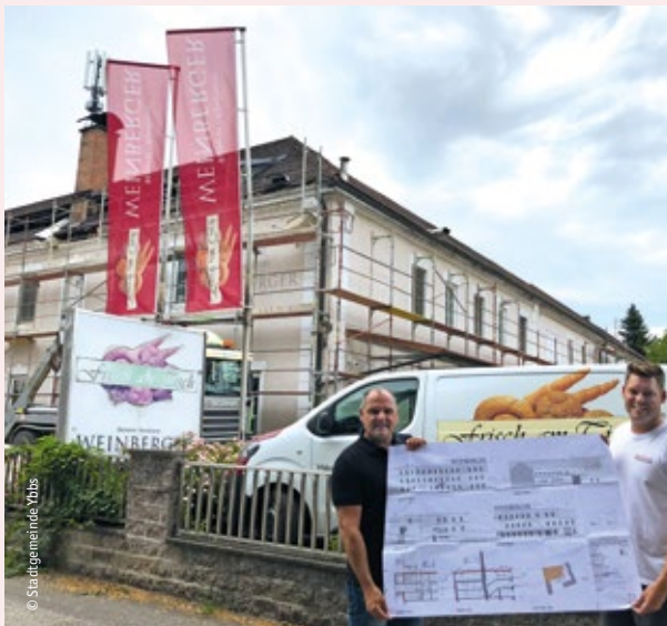
Geschäftsführer Alexander Weinberger zeigt Bürgermeister Alois Schroll den Baufortschritt.
