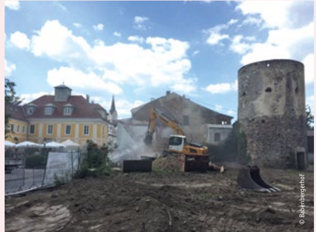
Bau des ersten Hotels in Ybbs „Donau Lodge“
